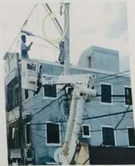
INSTALACIONES DE LAMPARAS DE ILUMINACIÓN EN LOS SECTORES PARANOTAR Y 20-30. GESTION 2024. ALCALDE OSWALDO RODRÍGUEZ. JULIO 2024
